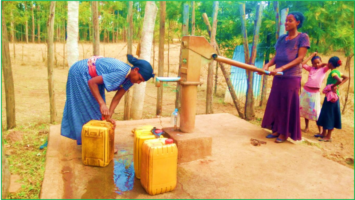
Villageoises, quelque part en Oromia, puisant l'eau à une borne installée par OSRA. Le règne des 'jerrycans' en plastique !
